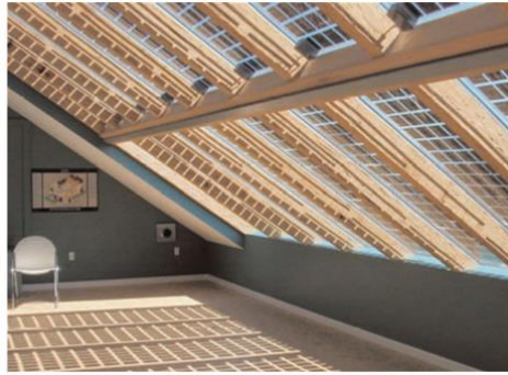
Figura 2-3 Fotografia e paneleve diellore transparente të çatisë
