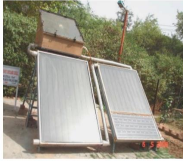
Figura 2-17 Fotografia e një sistemi diellor të integruar hibrid PVT.
