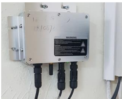
Figura 6-11: Mikroinverter dhe lidhja On-Grid me rrjetin
