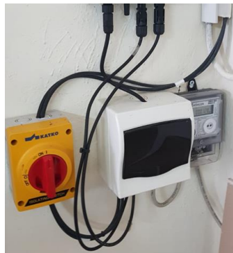
Figura 6-11: Mikroinverter dhe lidhja On-Grid me rrjetin
